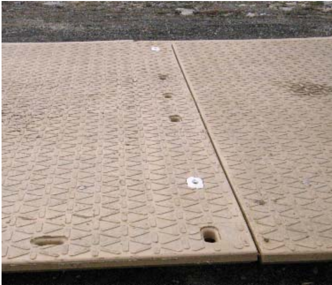
Abb. 24 Matten richtig ausgerichtet und verriegelt.
